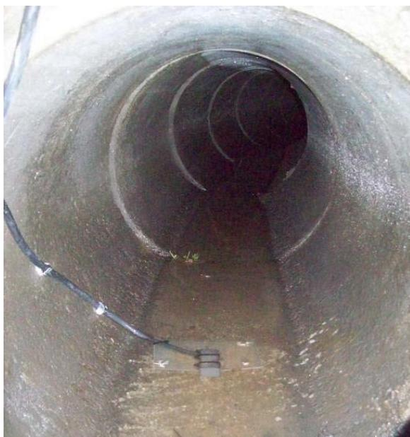
**Figura 8.- Conducto de vertido hacia el mar. Debido a la existencia de un punto alto en la rasante se acumula una pequeña lámina de agua de 2-3 cm en la zona de medida. Se aprecia la situación de la pastilla de medida de velocidad y de calado.**
