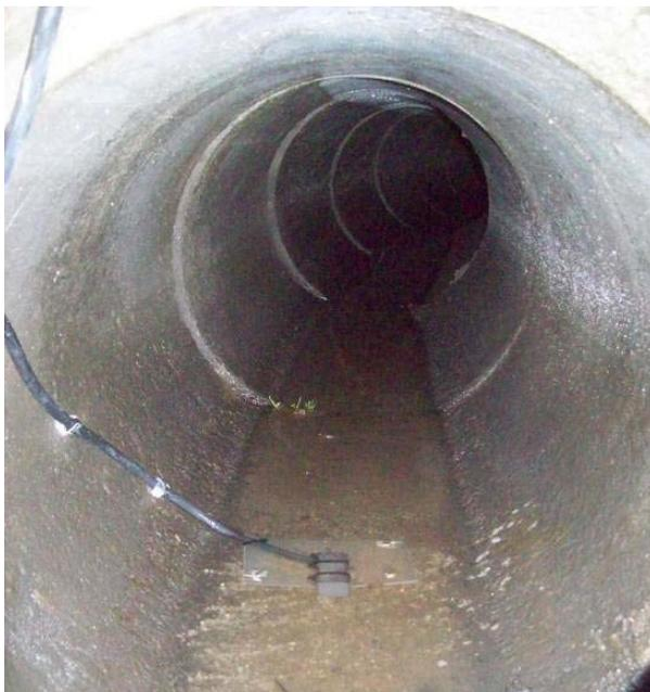
**Figura 9.- Conducto de vertido hacia el mar. Debido a la existencia de un punto alto en la rasante se acumula una pequeña lámina de agua de 2-3 cm en la zona de medida. Se aprecia la situación de la pastilla de medida de velocidad y de calado.**
