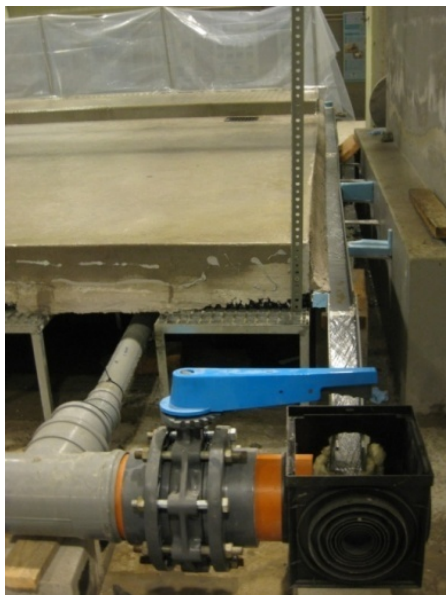
Figura 3.5 Canaleta de evacuación con la llave de paso en primer plano.
